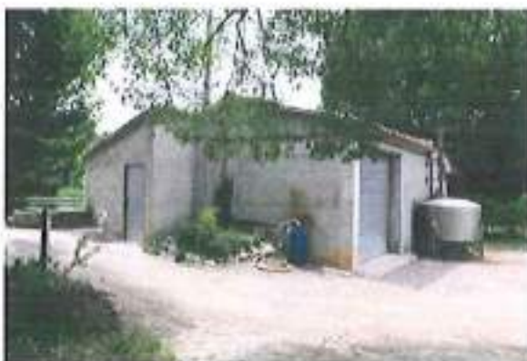
Cobert d'instal·lacions auxiliars del camp
