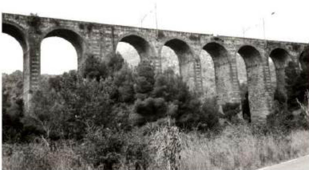
Vista general del viaducte. M.A. Monte
