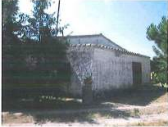
Façana posterior, nord-oest
