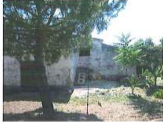
Façana posterior, sud-oest
