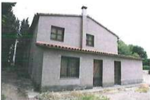
Façana lateral del mas (oest)
