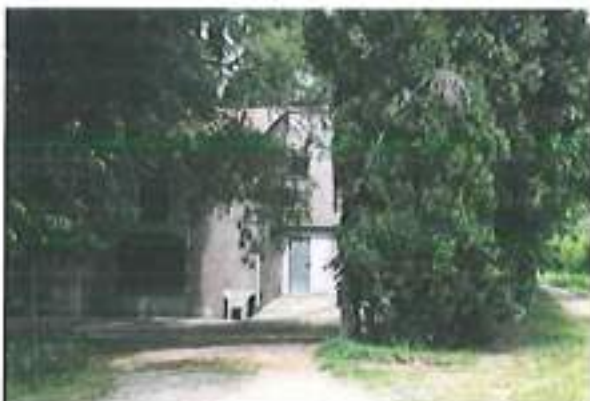
Part est de la façana principal del mas (sud)
