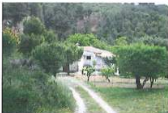
Façana oest des del camí d'accés
