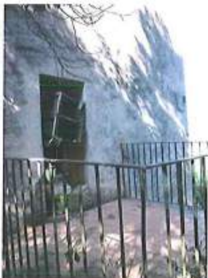
Façana nord, terrassa.
