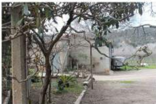
Façana est cobert d'instal·lacions
