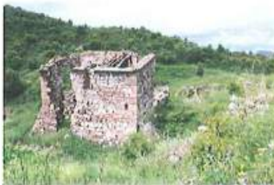
Façana est, el que conserva de coberta
