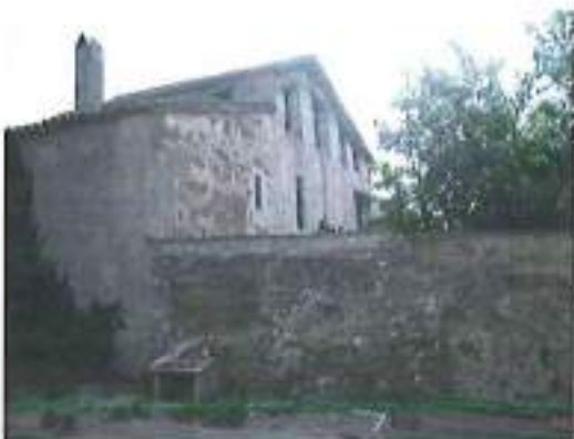
Façana principal, sud
