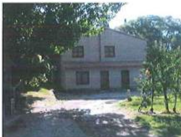
Façana lateral del mas (oest)
