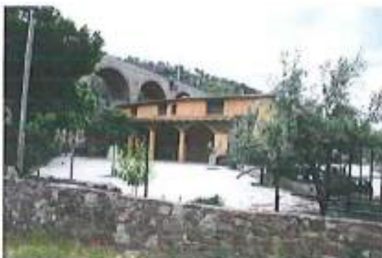
Vista des del camí d'accés, alçat nord
