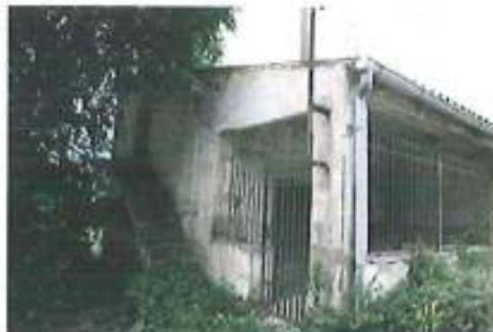
Façana sud, porxo i escala.
