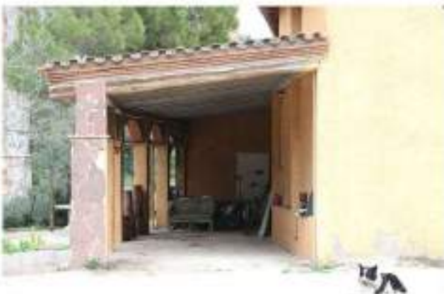
Detall porxo façana nord
