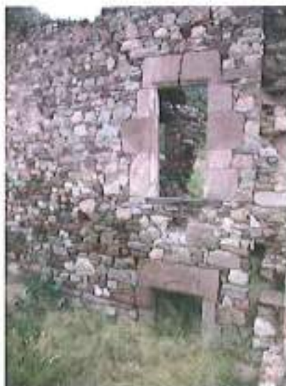
Mur de càrrega central de la masia amb portes a les dues plantes
