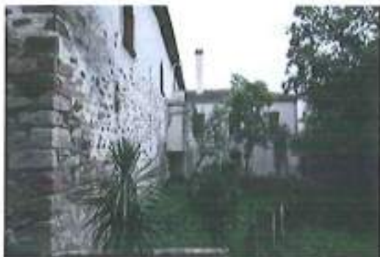
Façana nord, cos central i oest (al fons)
