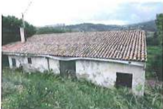
Façana est, la d'accés.
