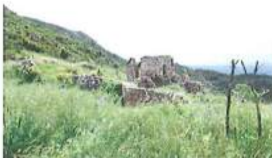
Façana oest amb els murs que resten de les edificacions auxiliars
