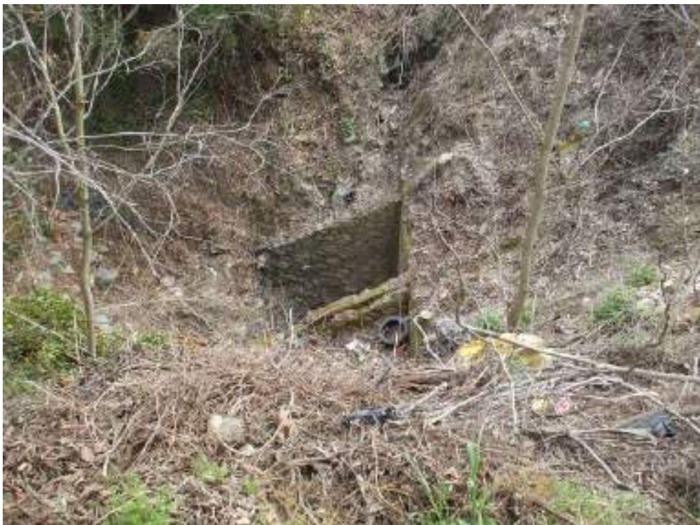
Fotografia 18: Pas del torrent de Reganer per sota la carretera B-121.
