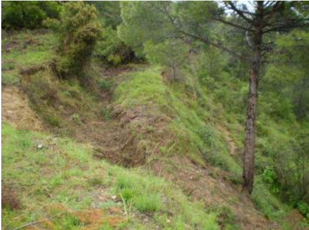
Fotografia 4: Escarpament de capçalera del possible lliscament de la subàrea A.
