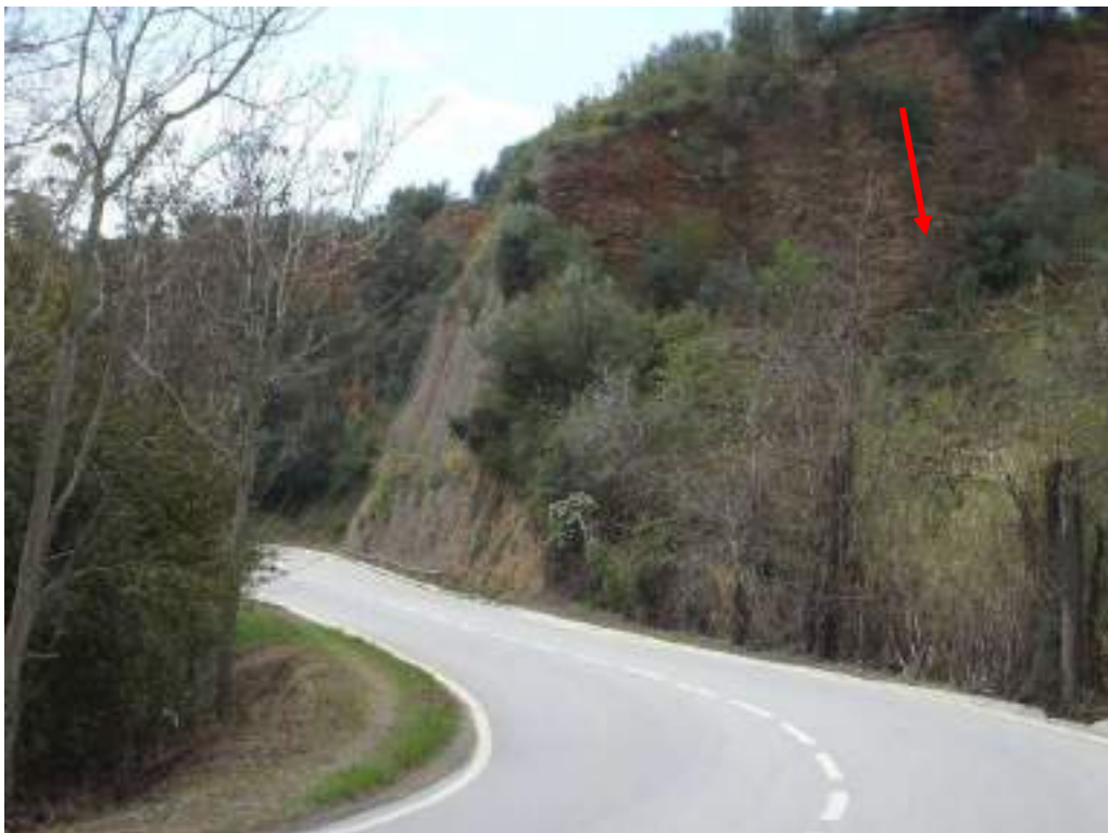
Fotografia 16: Detall del sector esllavissat proper a la carretera B-120, on s'observa el talús mallat.
